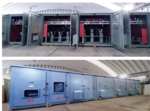
FILTRO AUTOMATICO DE ARMÉNICAS, 3500 kvar
